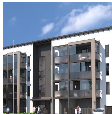
As Oy Tampereen Näsilinnankatu 40, D-talo
